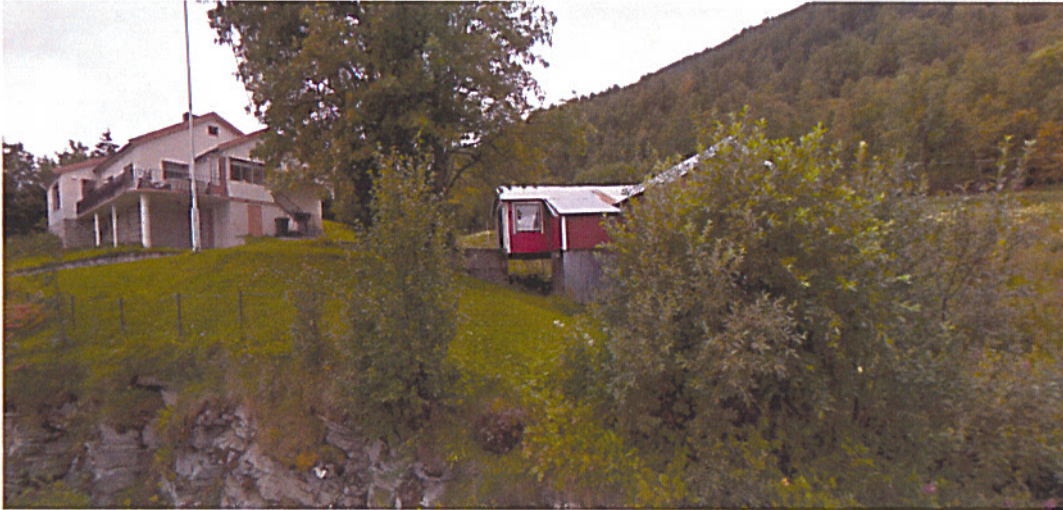
Figur 4: Bekkeløp indikert i Figur 3 går under driftsbygning (kilde: maps.google.com ).
