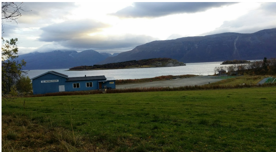
Klubbhuset på Geitnes idrettsanlegg
