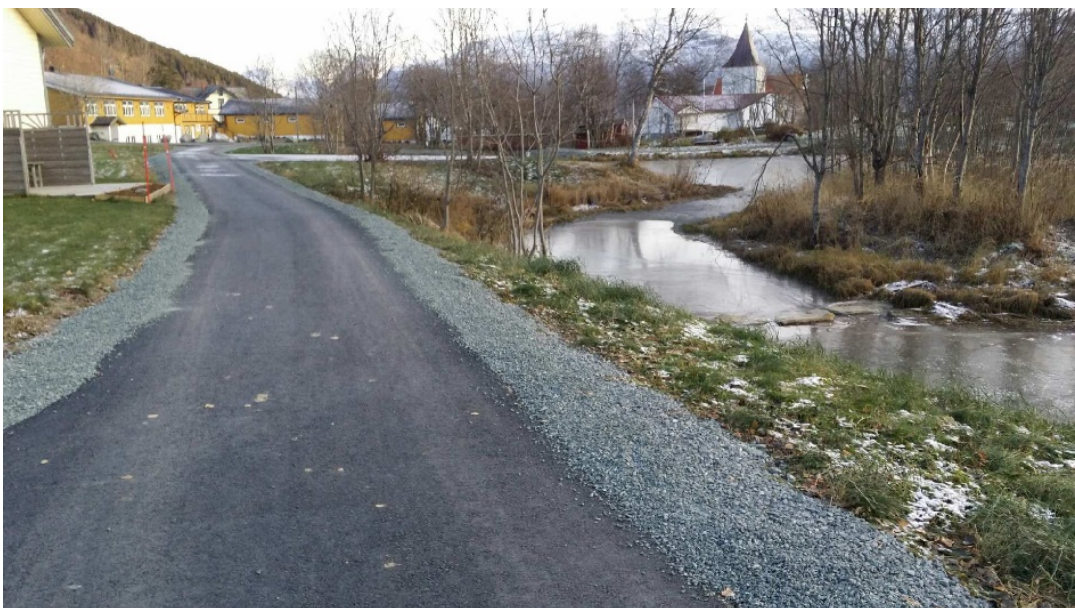
Prestelvparken skal bli nærmiljøanlegg
