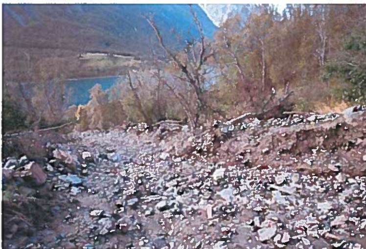
Stein og grusmassene i bekkeløpet graves opp og legges langs høyre siden av bekken (vestsiden). I svingen legges de oppgravde massene opp som en ledevoll, for på den måten holde et framtidig skred i bekkeløpet.
