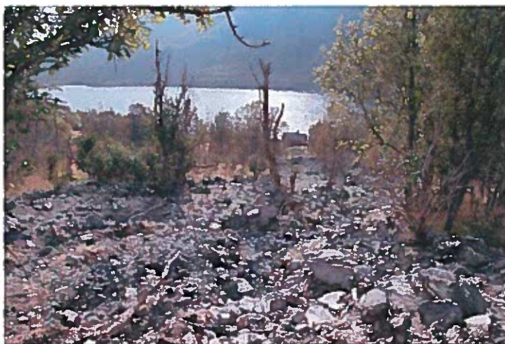
Bekkeløpet utvides, de oppgravde massene legges langs venstre bredd (østsiden) av bekken.
