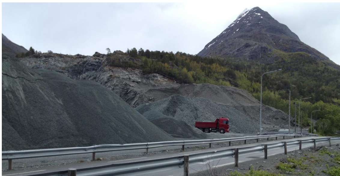
Fig. 5.4 Bildet tatt fra Fv91, fra vest mot nordøst, og viser dagens situasjon for uttaksområdet. Store hauger med ferdigmasse er lagret ut mot veien. Disse er synlige men skjerner for innsyn til uttaksområdet.
