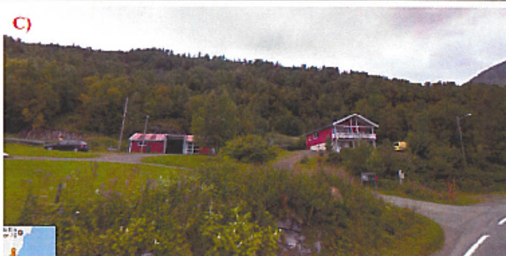
Figur 6: A) Veiskjæring ned mot planområdet på Vollnes. B) Veiskjæring nord i planområdet. C) Fjellsiden over Vollnes er dominert av tett løvskog (kilde: maps.google.com).
