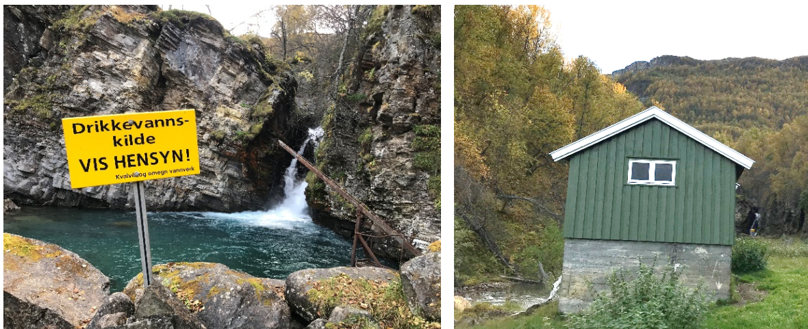
Figur 11. Inntaksbasseng Stelfossen (venstre) og trykkbasseng (høyre) (Foto: H. Kvitsand).
