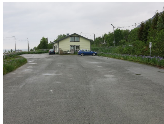
Foto 12. Oversikt over mulig lokalitet for etablering av permanent helikopterlandingsplass ved ambulansestasjonen i Sør-Lenangen. Foto: Viggo Jørn Dale.
